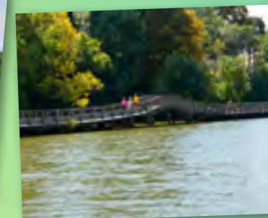
Passerelle sur l'Erdre à Nantes
